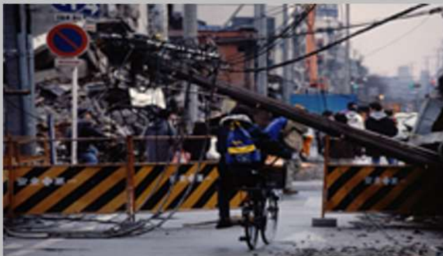
電柱の倒壊 (倒壊した電柱が道路を塞いでいる)
