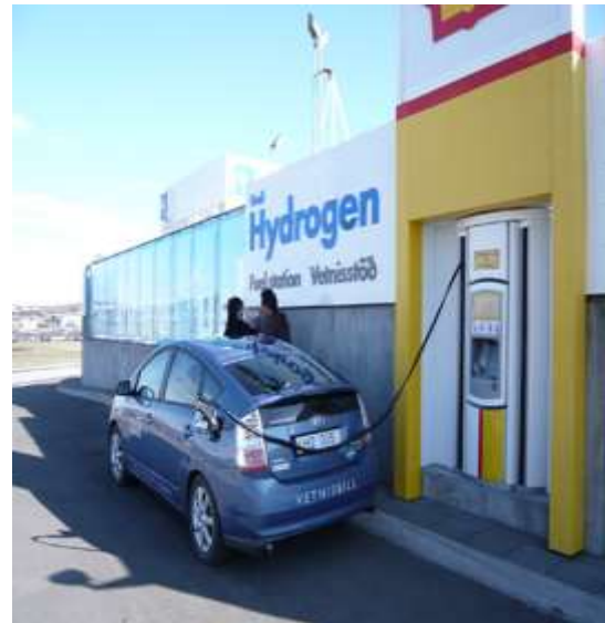
〔水素ステーション〕 25
