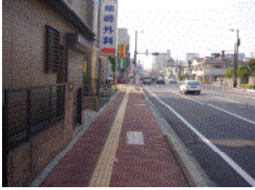
図 26 「幅員の狭い歩道」(宇都宮市平松本町・国道 123 号線 06 年 10 月 18 日現在大宅撮影)
